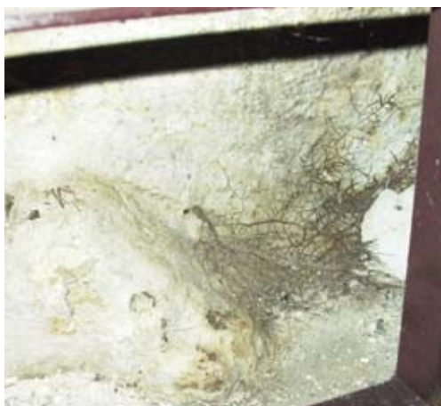
Mycelier eller rødder er trængt gennem muren.
