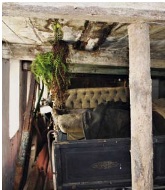
En bregne er trængt gennem loftet i magasinet.
