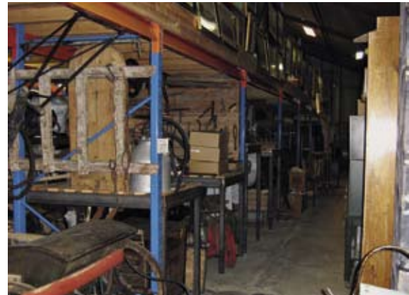
Et godt isoleret magasin, men der mangler en sluse, så man ikke går ind direkte udefra. Desuden bør gulvet males og museet bør have bedre plads, så genstandene ikke står i gangarealerne.
