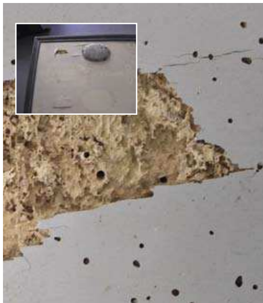
Borebillens larver lever af træ og æder træet indefra. Det synlige tegn er små huller og bunker af træmel på overfladen. Her ses en træplade i ramme, hvor der er åbnet op ind til det egentlige angreb..
