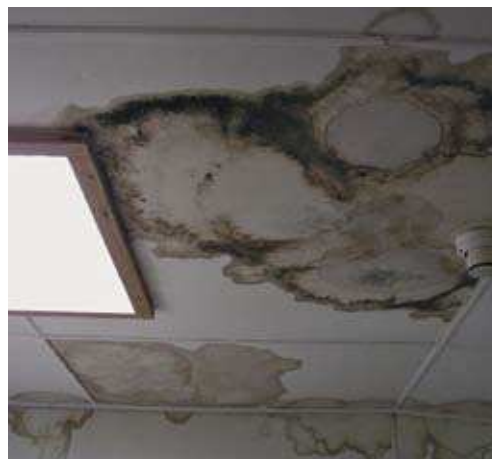
Utætte lofter og mure i museumsmagasiner er med til at ødelægge indeklimaet i et magasin.
