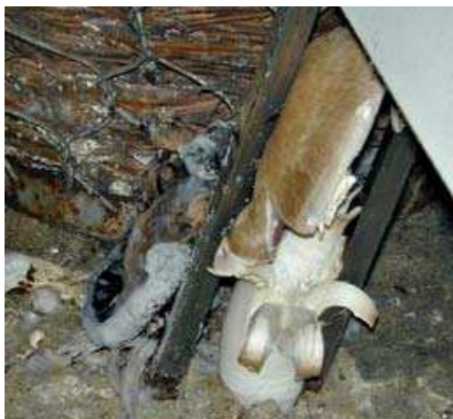
Ved et for fugtigt indeklima dannes der ofte skimmel og i dette tilfælde en regulær svamp.
